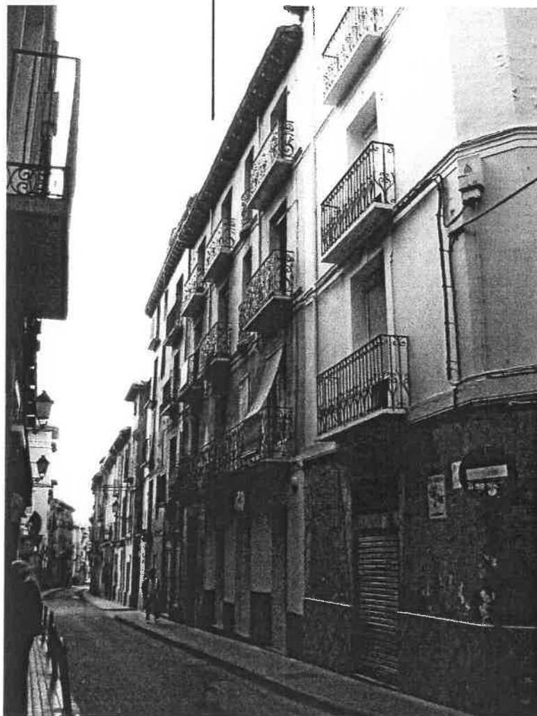
CALLE SAN LORENZO N° 10. EDIFICIO CATALOGADO EN GRADO 3°.
