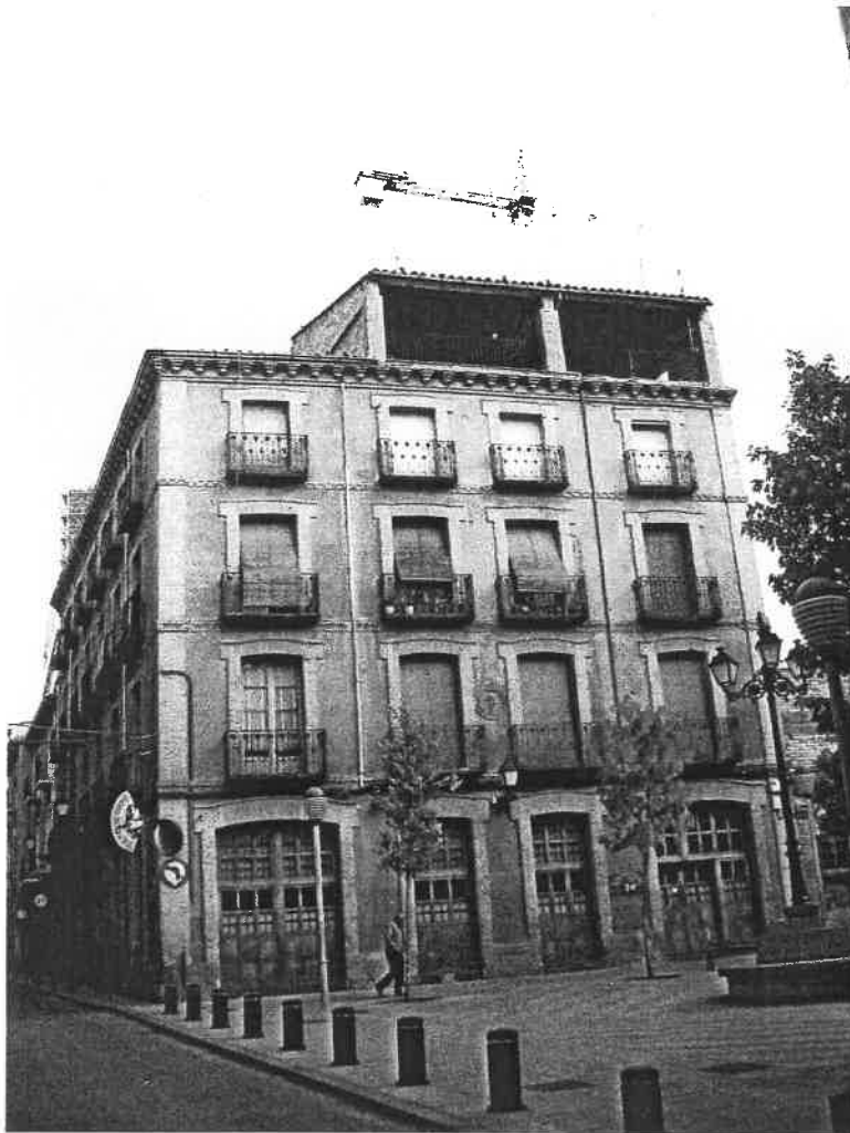
CALLE SAN LORENZO Nº 13. EDIFICIO CATALOGADO EN GRADO 2º.
