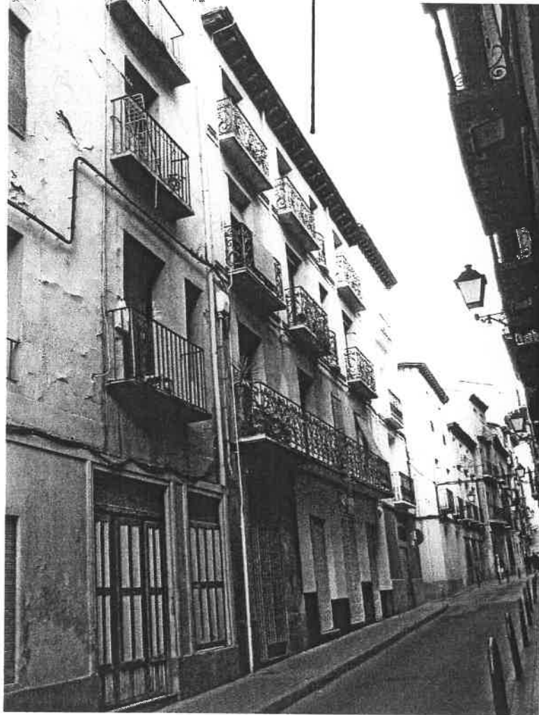
CALLE SAN LORENZO Nº 10. EDIFICIO CATALOGADO EN GRADO 3º.
