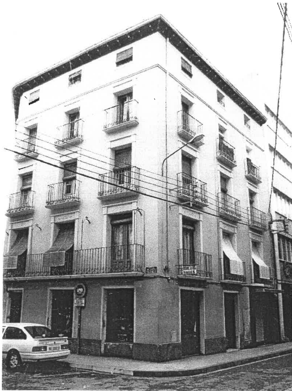
CALLE BERENGUER Nº 10 EDIFICIO CATALOGADO EN GRADU 2º.
