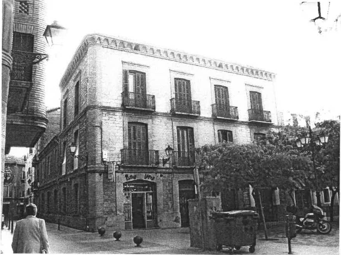
PLAZA ALFONSO EL BATALLADOR Nº 2. EDIFICIO CATALOGADO EN GRADO 2º.
