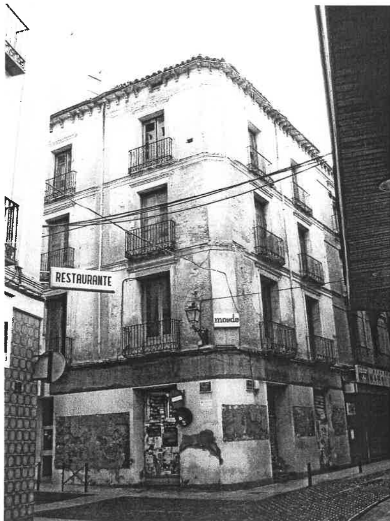
CALLE PADRE HUESCA Nº 3. EDIFICIO CATALOGADO EN GRADO 3°.
