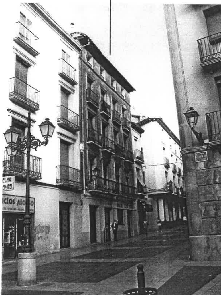
CALLE PADRE HUESCA Nº 12. EDIFICIO CATALOGADO EN GRADO 3º.
