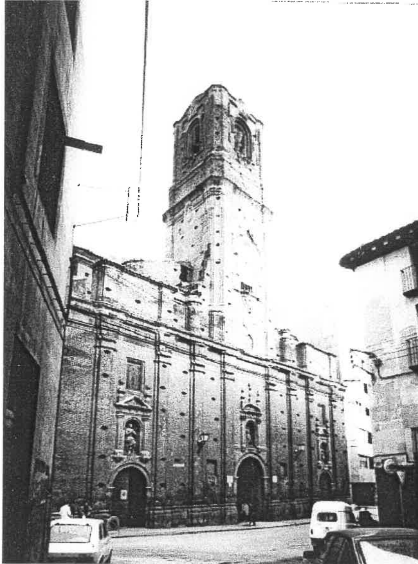
PLAZA SAN LORENZO Nº 3. EDIFICIO CATALOGADO EN GRADO 1º.
